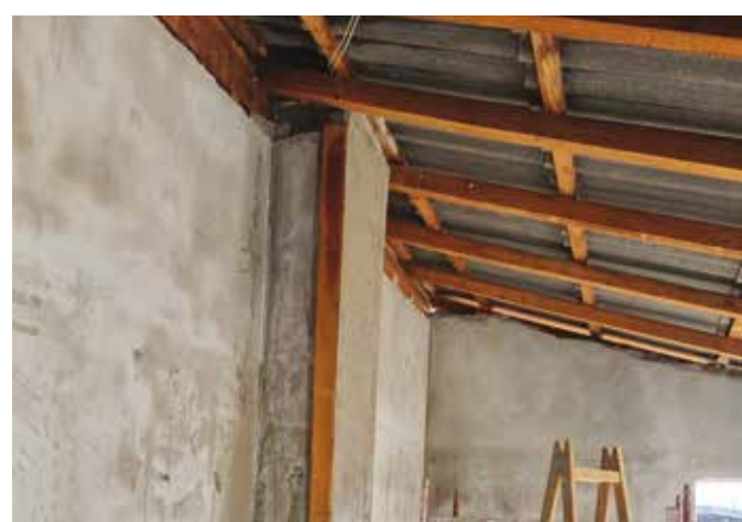
Zamenjava strešne konstrukcije in vgradnja strešnih oken
