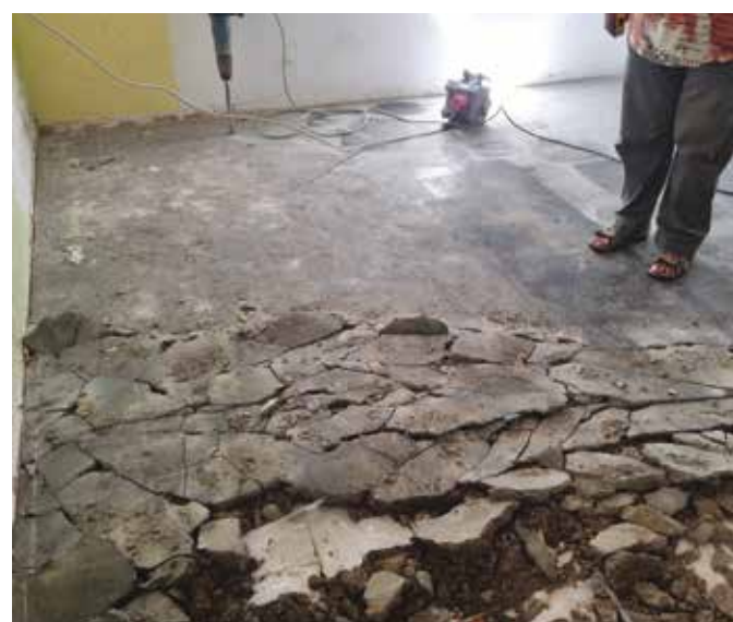
Zamenjava talne konstrukcije in tlakov
