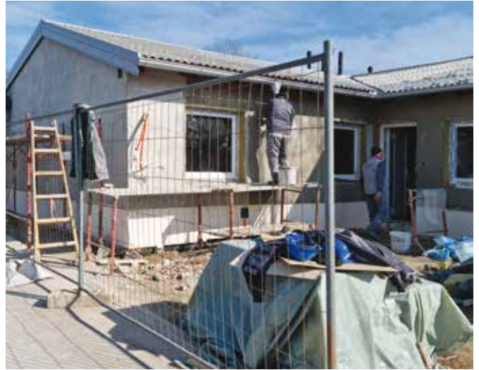
Toplotna izolacija fasade
