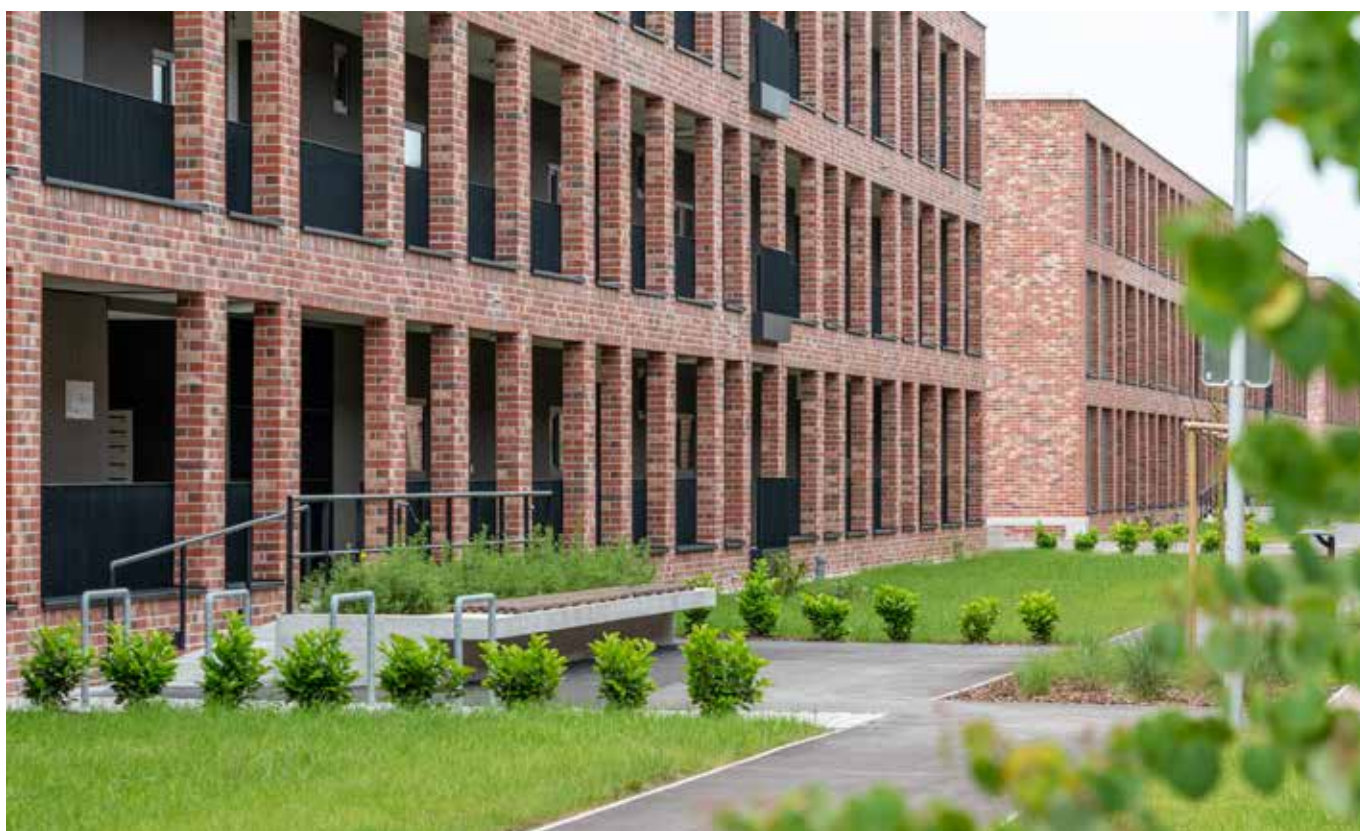
Pogled na severno stran stanovanjskih objektov – bloki B
