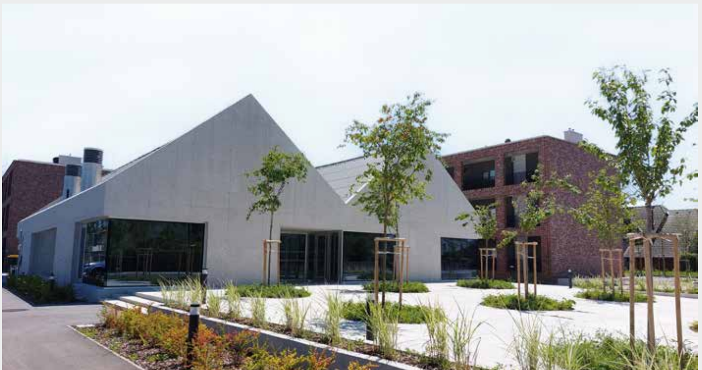
Pogled na večnamenski objekt
